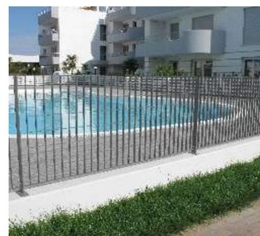
Tutte le opere in ferro saranno verniciate con una mano di antiruggine e due mani di smalto RAL di colore a scelta della Direzione Lavori.
