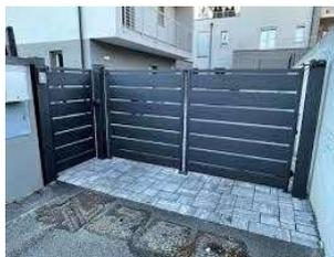
Il cancello di ingresso carraio sarà realizzato in ferro a disegno semplice a doghe orizzontali, con apertura del tipo scorrevole completo di motorizzazione elettrica con comando a distanza (telecomando bicanale in numero 1 per unità abitativa)
