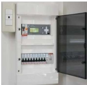
N° 1 Centralino posto immediatamente a valle della fornitura ENEL, completo di interruttore magnetotermico-differenziale ad uso generale ed un interruttore di protezione della propria linea.
